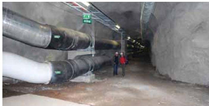
Ogled največje toplotne črpalke na svetu, Katri Vale, ki Helsinke oskrbuje z energijo za ogrevanje in za hlajenje. Uporabljajo očiščeno kanalizacijsko vodo in morskovo vodo. Proizvedejo 90 MW energije za ogrevanje in 60 MW za hlajenje mesta.
